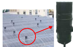
ハウス換気用の空動扇
